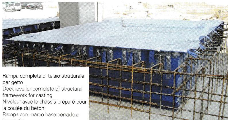
Rampa completa di telaio strutturale per getto
